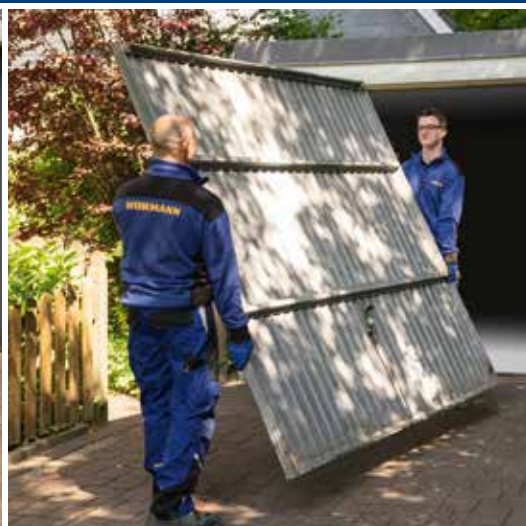
Demontaż i ekologiczna utylizacja
