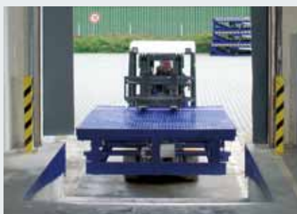
Osadzenie nowej ramy przeładunkowej
