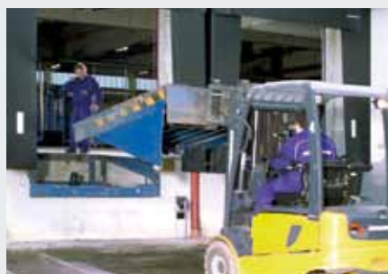
Demontaż starej ramy przeładunkowej i starej ramy samonośnej, ewentualne dopasowanie z zastosowaniem profili adaptera
