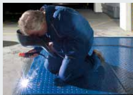
Spawanie do kątowników krawędziowych – gotowe!
